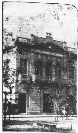
Edificio en la Sociedad Italiana de S.M. XX de Septiembre, posado en la Plaza 9 de Julio
